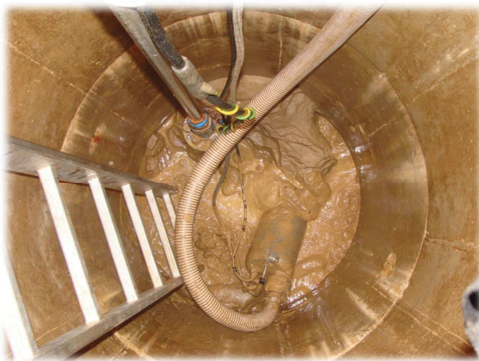
Jemný kal na dně studny při čištění
