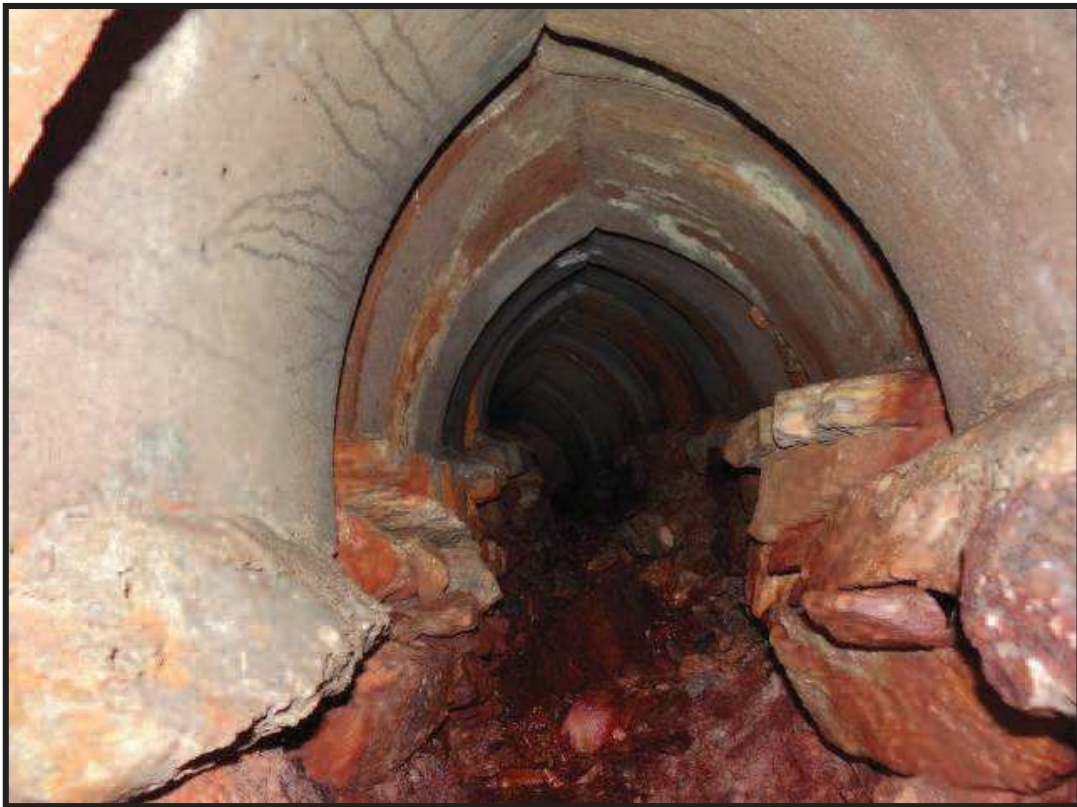
Obr. 1: kontrolní štola jímacího objektu HJ-3, prameniště Bátovka, foto R. Kalousek 2015
